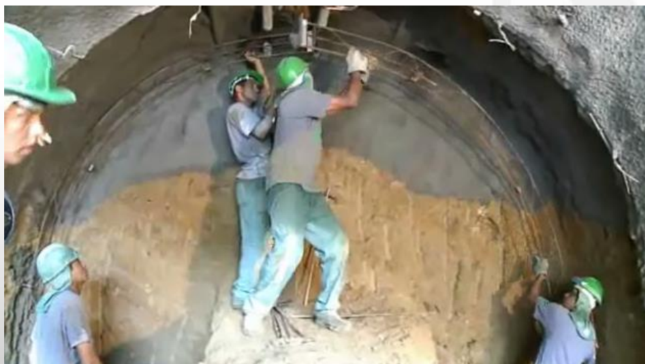
3 – Colocação de cambotas metálicas
