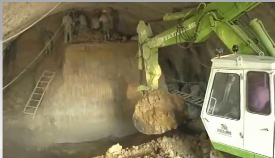
2 – Escavação (seção plena x seção parcializada)
