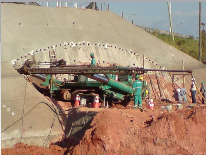
1 – Execução das enfilagens (“forepoles”)
