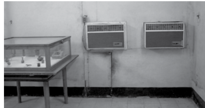
Figura 16. Um típico museu de pequeno porte com aparelhos de ar condicionado. Eles costumam causar tanto dano aos artefatos quanto conforto a visitantes e funcionários. São uma fonte de gotejamento de água e alteração de umidade relativa.
