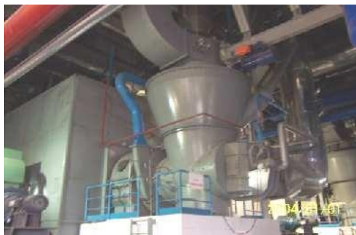
Figura 1 - Uma das extremidades de um moinho de dupla entrada, destacando-se os munhões, entradas de carvão bruto e ar primário e saída do material pulverizado para os queimadores.
